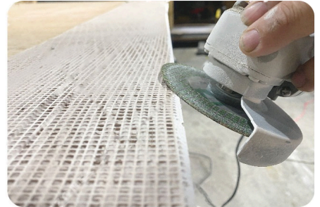
1 משייפים במשחתת זווית את קצה הלוח באזור חיבור הפילה לזווית של 45°.
