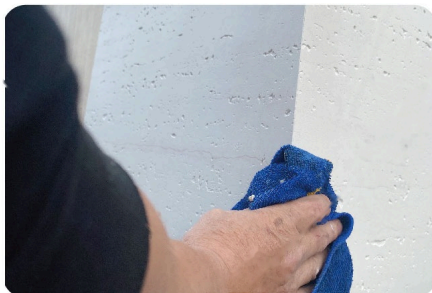
5 כשהדבק מיובש למחצה, מנקים את שאריות הדבק שנזלו בעזרת מטלית לכה.
