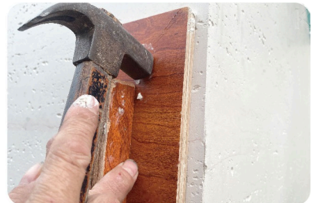
4 לאחר ההצמדה לקיר, לוחצים ומוציאים את הדבק בעזרת לוח לחיצה, כך שימלא באופן טבעי את מרווח הפילה בזווית 45°.
